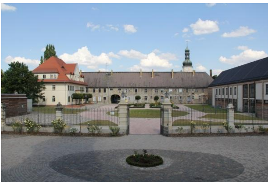
Das Torhaus vor der Sanierung
